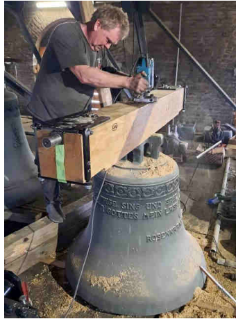
Das „Glocken-Joch“ wird ausgefräst + die Glocke auf den Glockenstuhl gehängt. Foto: Martin Lehrer
