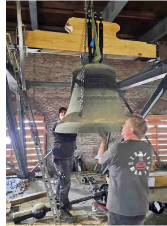
Das „Glocken-Joch“ wird ausgefräst + die Glocke auf den Glockenstuhl gehängt. Foto: Martin Lehrer
